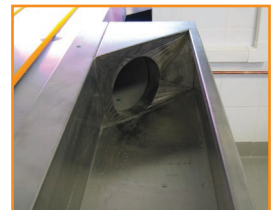
Plot humide avec canal d'évacuation
